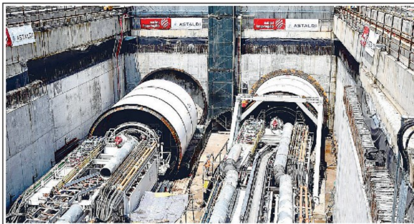
Il cantiere di San Cristoforo dove sono partite ieri le talpe [Uff stampa]
