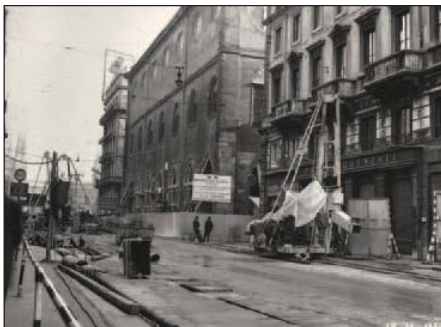
Via e piazza Mercanti mentre fervono i lavori per la realizzazione della linea 1 della Metropolitana milanese: è il 1959 (Guenzati)
